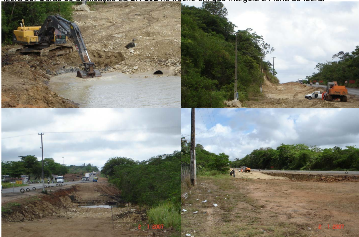
Figura 35: Obras de duplicação da BR 101 no trecho em que margeia a Flona do Ibura.
