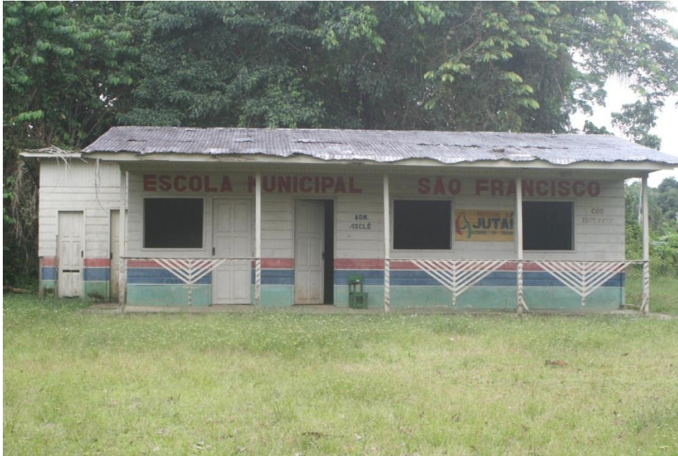
Figura 3.20 Escola Municipal São Francisco na comunidade Capivara
