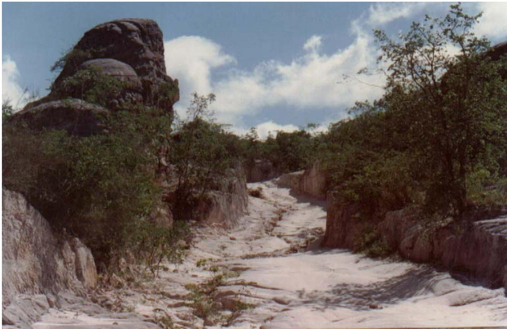
**Foto 21: Estrada dentro do Parque onde podem ser observados processos erosivos.**
