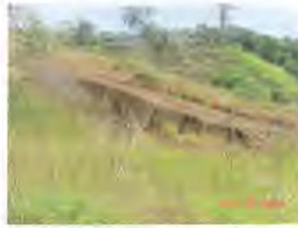
**Figura 6.6** – Processo de erosão/voçoroca pela movimentação de terra quando da implantação da estrada de ferro.
