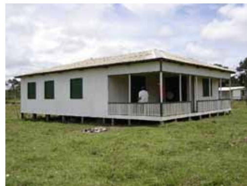
30. Base de apoio do IBAMA, construída no Núcleo do Cazumbá
