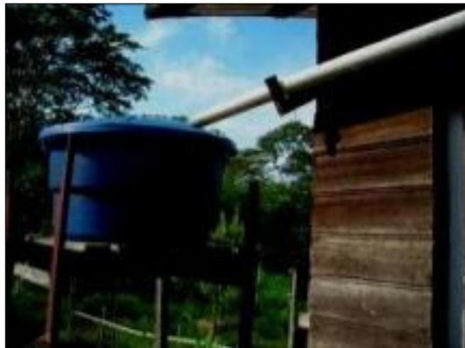
Figura 68. Foto coleta de água da chuva (HIGUCHI, 2008)
